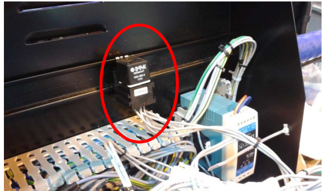
(Abb.6) Beispiel: Schaltanlage NT2500
