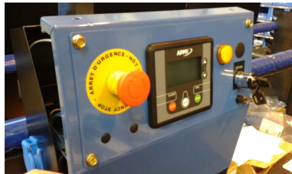
(Abb.4) Beispiel: Schaltanlage NT2500
