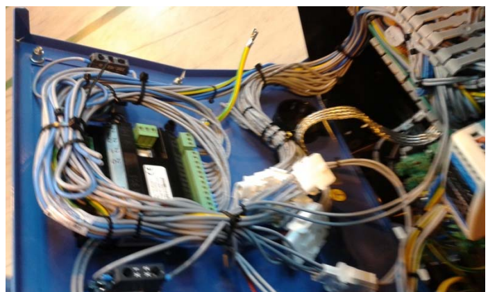
(Abb.8) Beispiel: Schaltanlage NT2500
